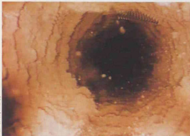
Trinkwasserbrunnen setzen sich mit biologischen Filmen zu (links). Ultraschall macht den Schacht wieder blitzblank (rechts).
