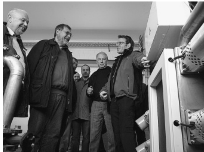
Faszinierte die Dänen: die „Blackbox“ (rechts) mit der Desintegrationsanlage, die den Stickstoffgehalt der Abwässer deutlich reduziert.
