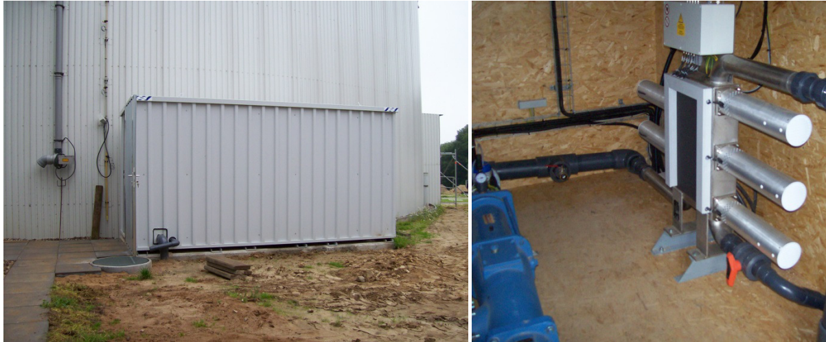
Abbildung 1: Container mit Anlage von außen und innen (mit US-Modul und Pumpe)
