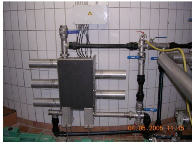
Abb. 1: Einbindung des Ultraschallreaktors in den Schlammbehandlungsprozess
