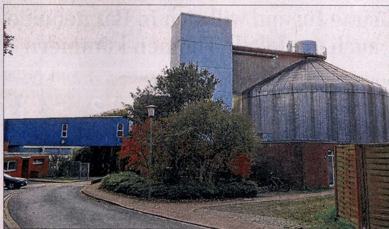
Die Ahrensburger Kläranlage an der Bünningstedter Straße ist die innovativste im Kreis Stormarn.
